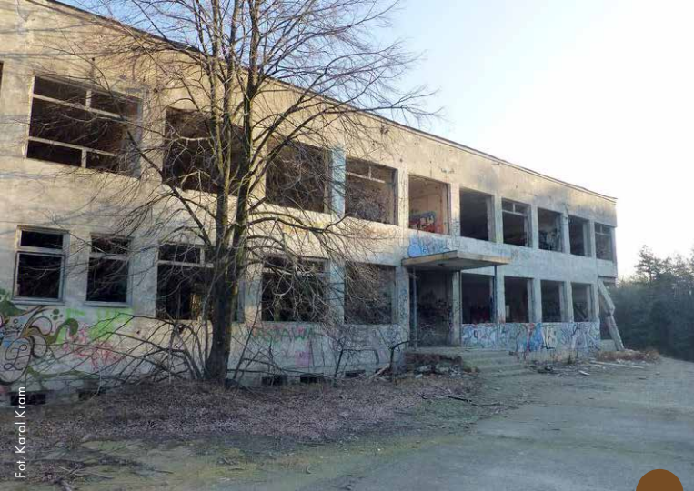
Budynek koszar przed rozbiórką
