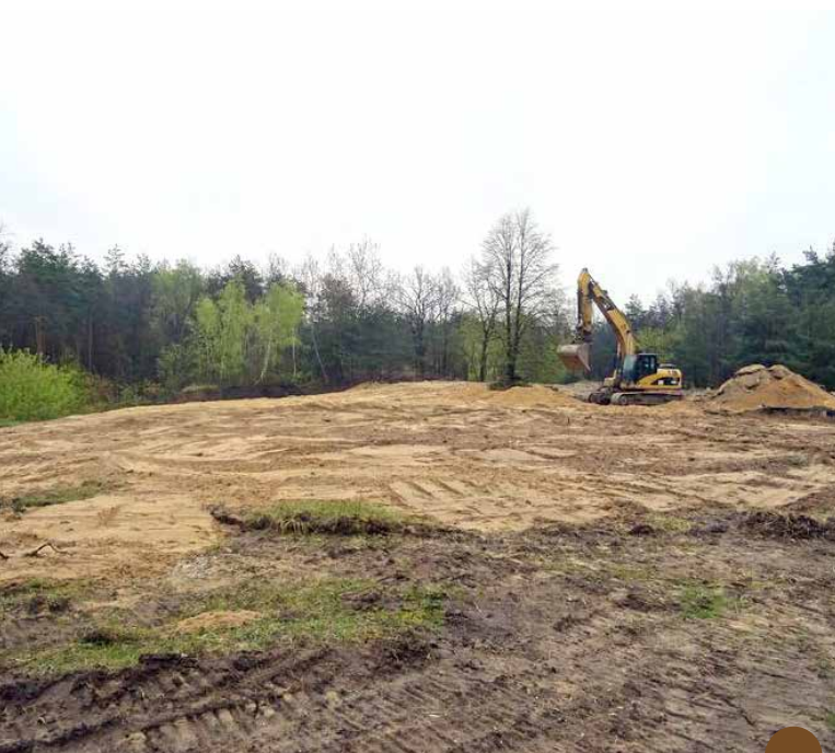
Teren po rozbiórce
