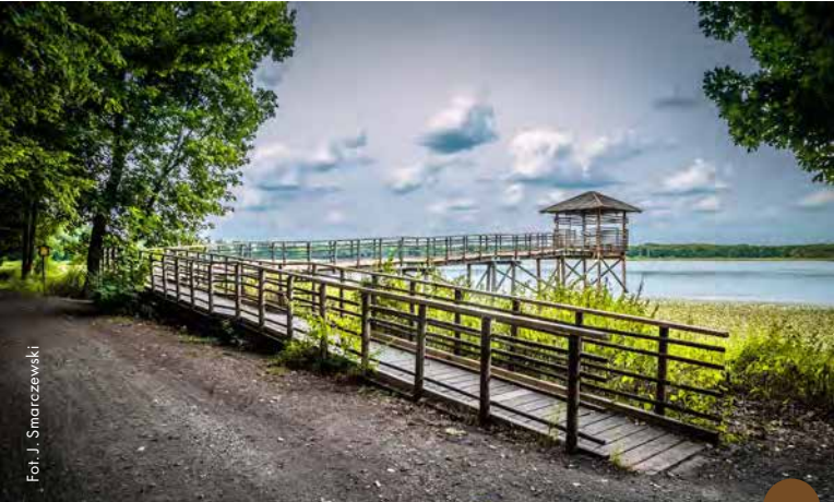
Wieża posiada dostęp dla osób niepełnosprawnych
