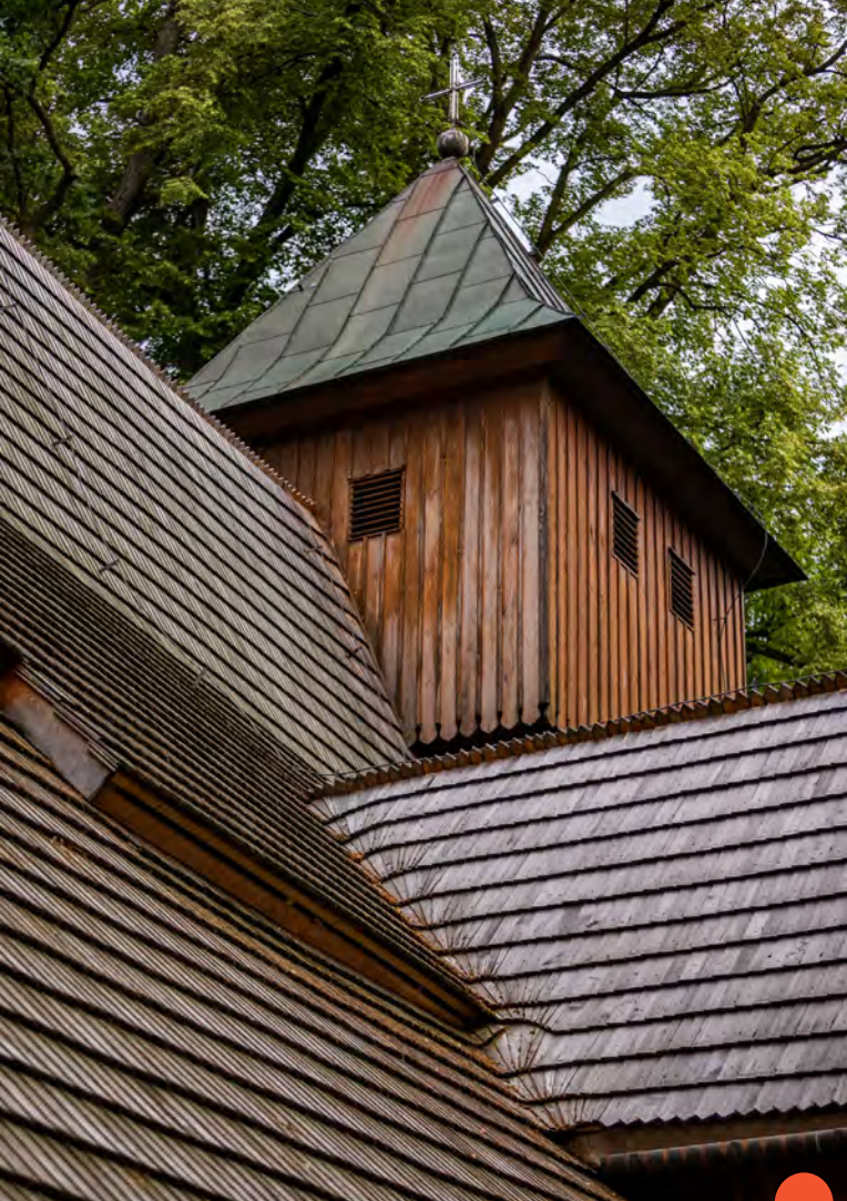
Otwory wlotowe na strychnię w kościele w Gruszowie
